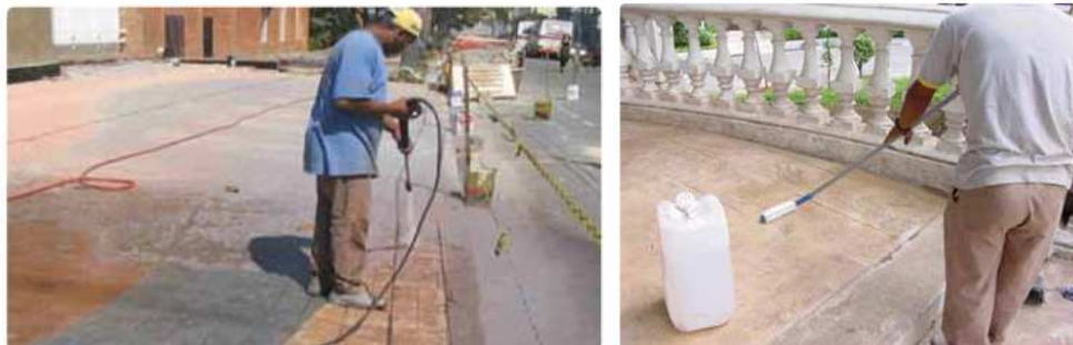
Lavagem e aplicação do endurecedor - © ABCP
