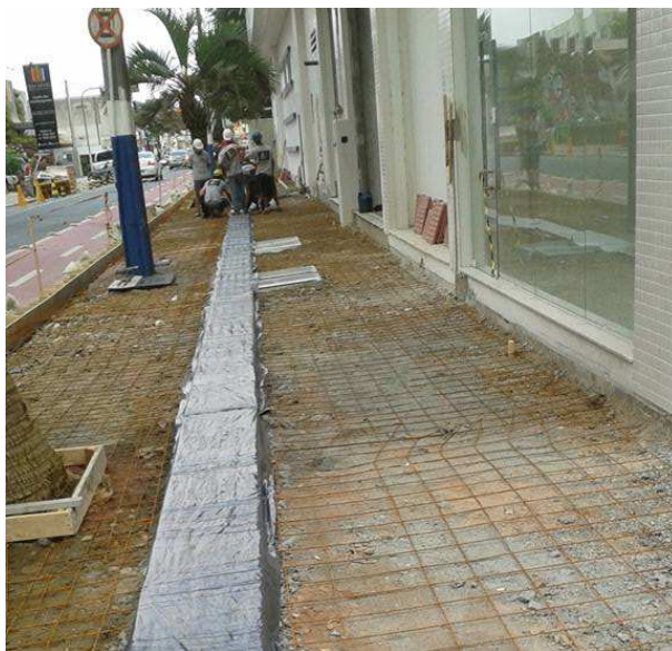
Proteção das placas táteis com lona plástica
