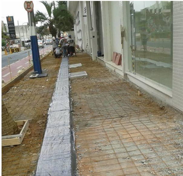
Proteção das placas táteis com lona plástica
