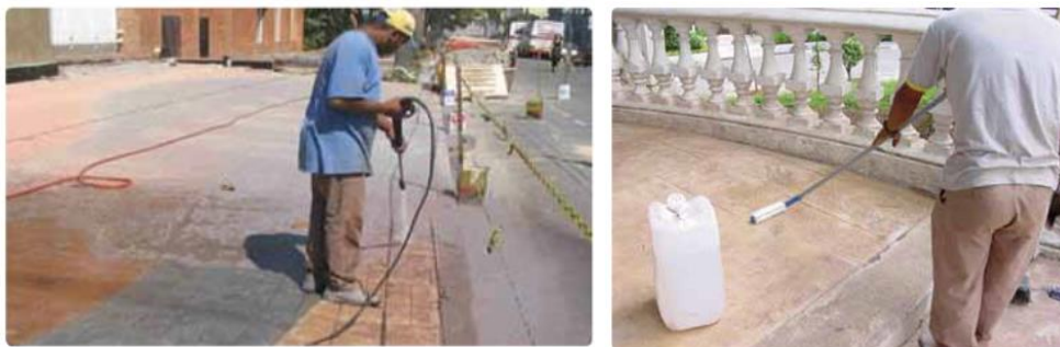
Lavagem e aplicação do endurecedor - © ABCP
