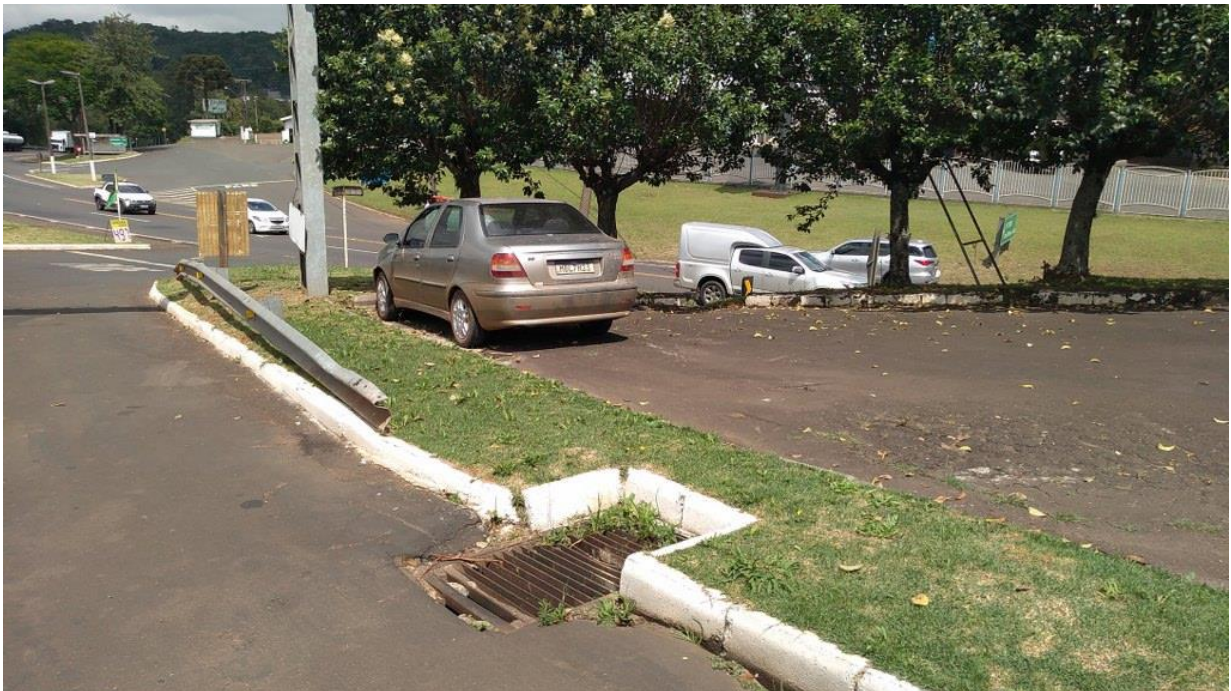
Imagem 06: A drenagem pluvial será adequada com a realocação de bocas de lobo.
