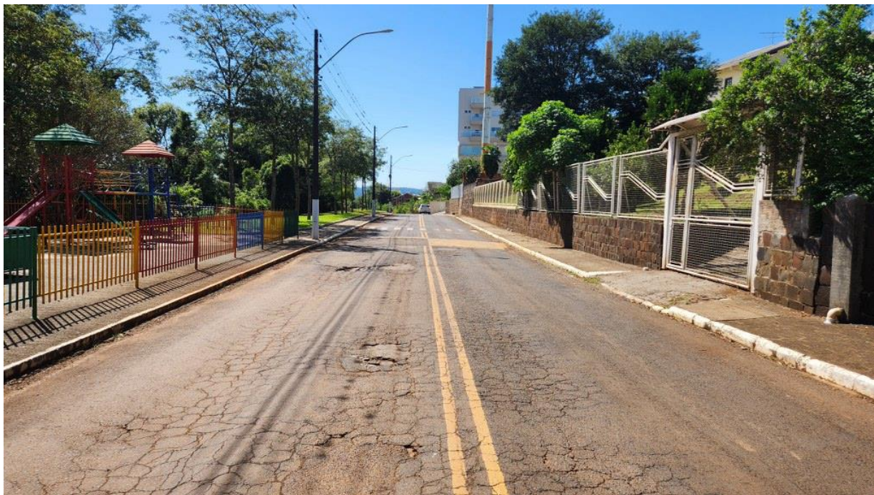
Imagem 02: Pavimento asfáltico a ser fresado e reconstituído com nova camada de rolamento.
