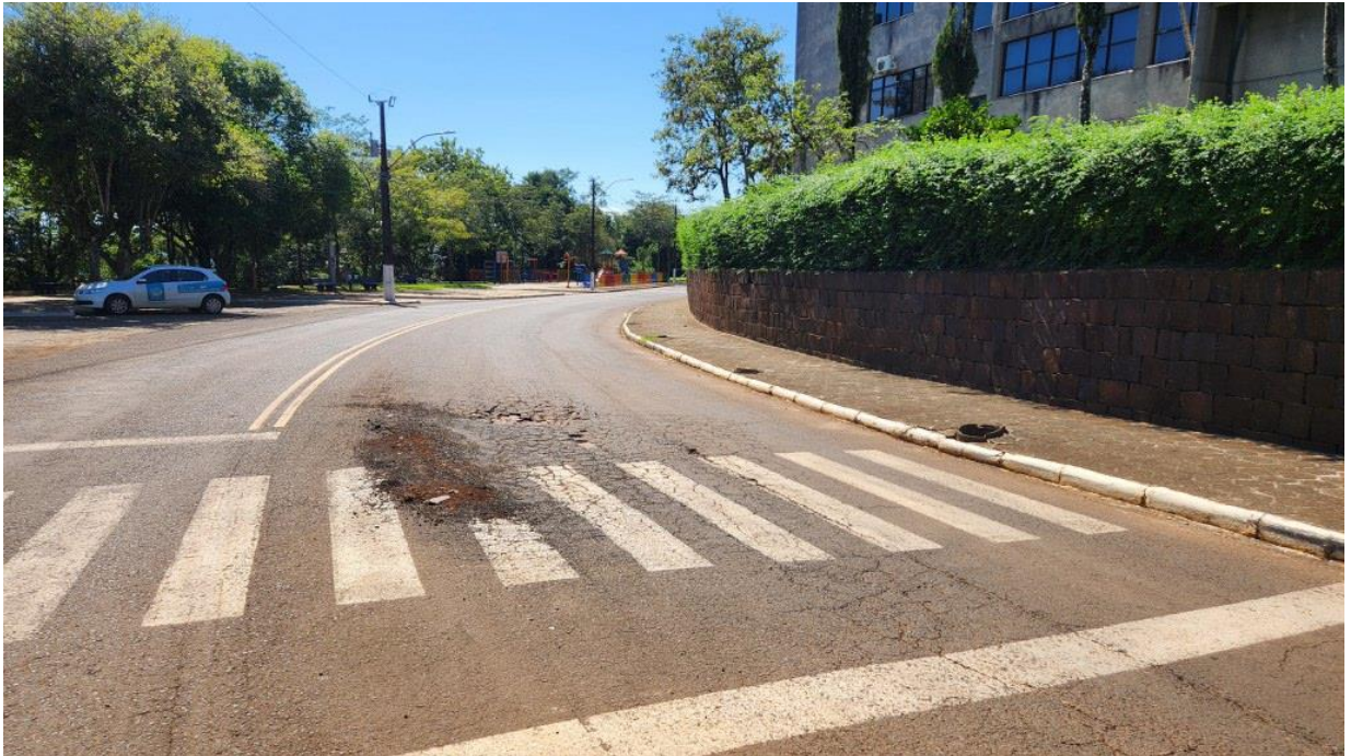
Imagem 04: Local em que será realizado reforço na sub-base e base do pavimento.
