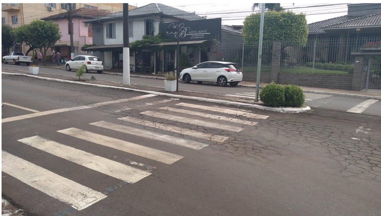
Imagem 03: Canteiros a serem removidos e após a escavação do solo e execução da sub-base e base, o pavimento asfáltico será reconstituído com nova camada de rolamento.
