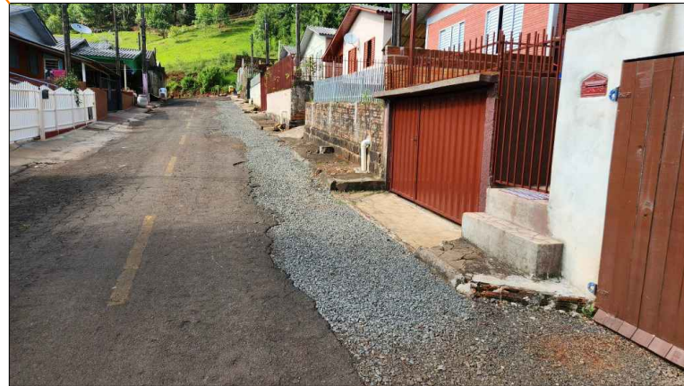
Será reconstituído um trecho da tubulação da rede de esgoto
