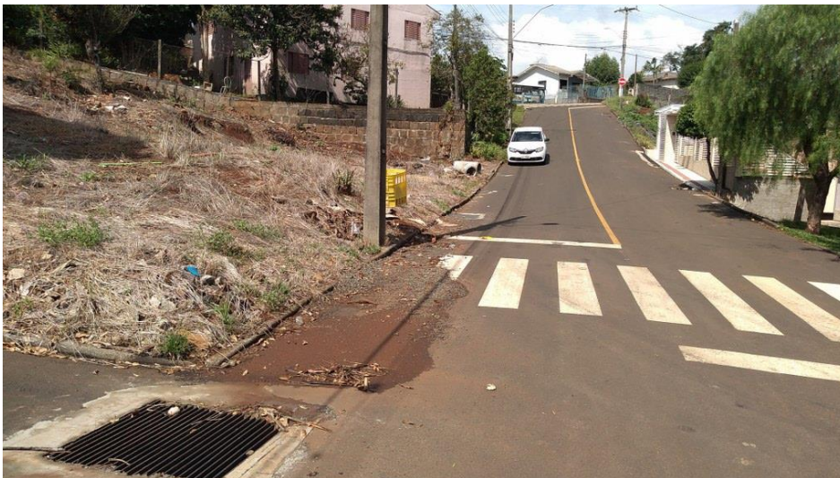
Boca de lobo que receberá a nova vazão das águas pluviais.
