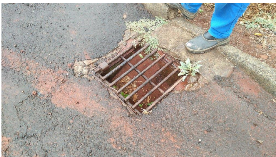
Visão da boca de lobo totalmente entupida com solo.
