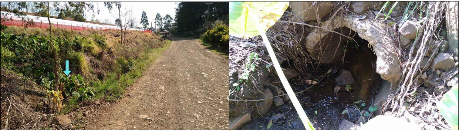
Bueiro existente com Ø40 que será substituído por Ø60.
