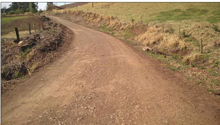
Local em que será complementado o bueiro de Ø60 e aterro da lateral da pista em 3,0 m para ampliar a largura da via de 5,0 m para 8,0 m.
