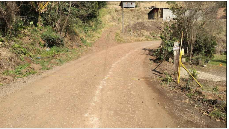
Largura insuficiente para a pista - deverá ser recuado o portão 2,0m.
