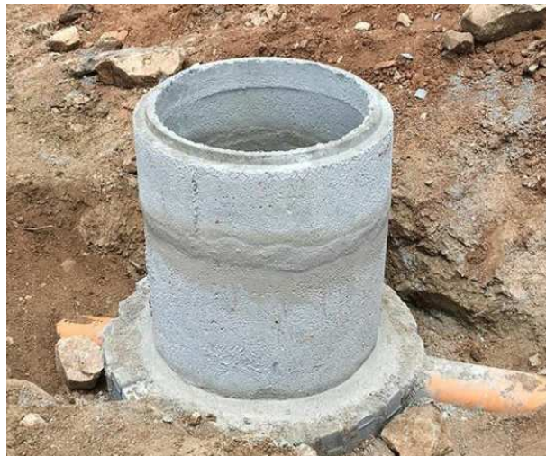
FIGURA 10 – RAMAL DE LIGAÇÃO COM TUBO DE CONCRETO
