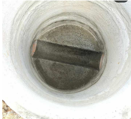
FIGURA 10 – RAMAL DE LIGAÇÃO COM TUBO DE CONCRETO
