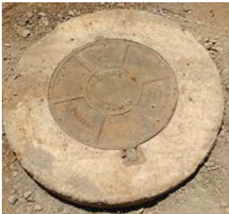
FIGURA 5 – MODELO DE TAMPA PARA POÇO DE VISITA
