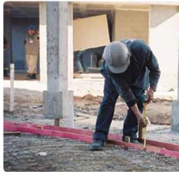
Fixação das fôrmas de madeira e conferência das espessuras mínimas - © ABCP
