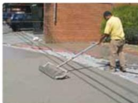
Sarrafeamento do concreto e rebaixamento do agregado - © ABCP
