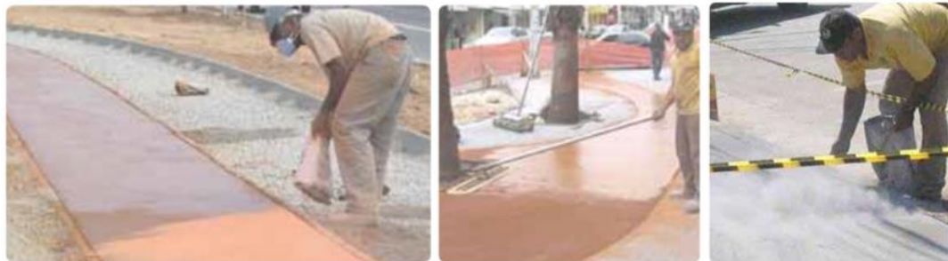
Lançamento do pó endurecedor, queima do endurecedor e lançamento do desmoldante - © ABCP
