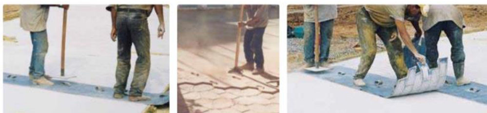
Estampagem do piso, compressão dos moldes e posicionamento das estampas - © ABCP
