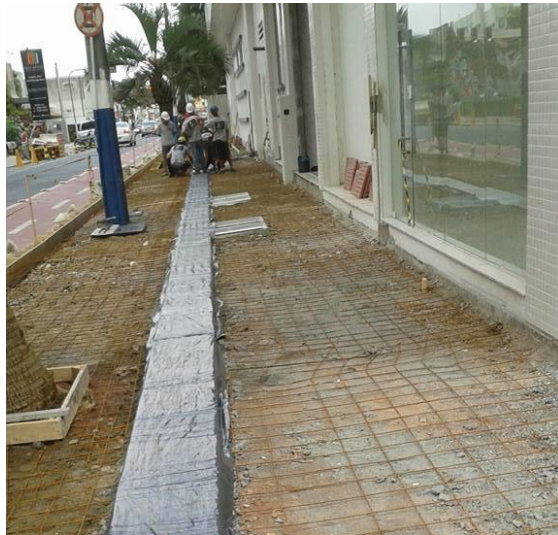
Proteção das placas táteis com lona plástica
