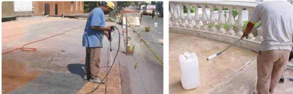
Lavagem para retirada do Desmoldante e aplicação da resina - © ABCP
