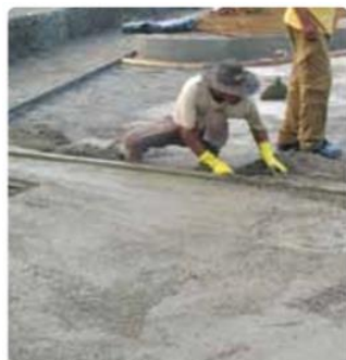
Sarrafeamento do concreto e rebaixamento do agregado - © ABCP
