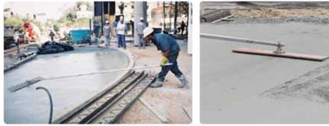
Desempeno do concreto - © ABCP
