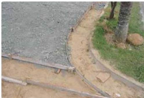
Fixação das fôrmas de madeira e conferência das espessuras mínimas - © ABCP
