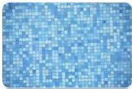
Parede de uma piscina
