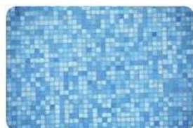
Parede de uma piscina
